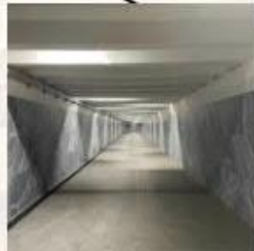
Транспортные подземные сооружения городской инфраструктуры (автомобильные и железнодорожные подземные тоннели, подземные переходы)
